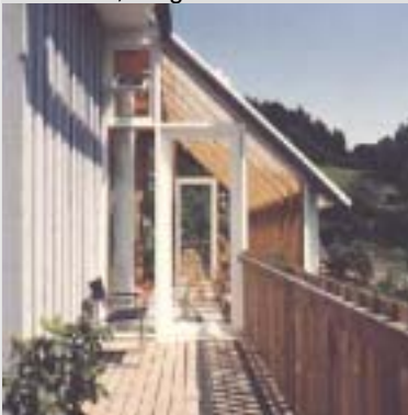
Am Balkon, Haus Frei, Vlbg.
